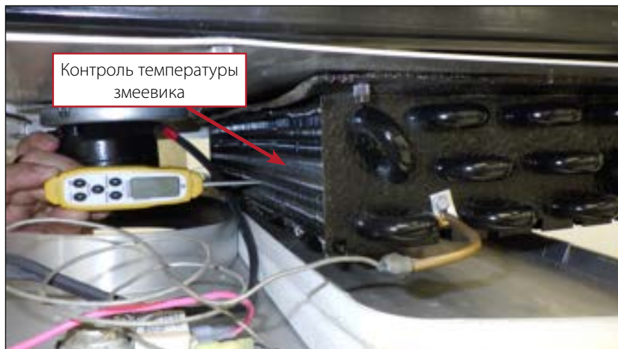
Рис. 1. Для терморегуляторов, работающих на основе измерения температуры змеевика, проверять температуру змеевика как можно ближе к датчику внутри испарительного змеевика.
