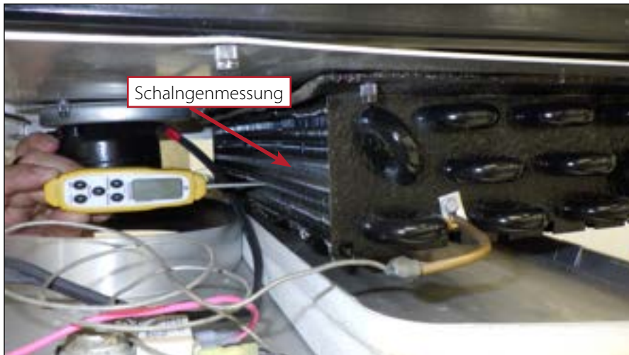
Abb. 1. Für Regelungen mit Rohrschlangenmessung prüfen Sie die Rohrschlagentemperatur so nah am Sensor wie möglich.
