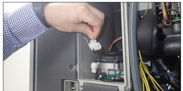
Fig. 2. Conector molex del interruptor de proximidad (desconectado).
