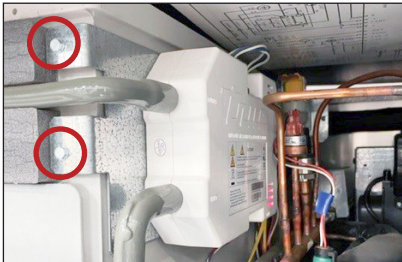
Fig. 3. Vista lateral del sistema de luz ultravioleta de TRUEZONE. Ubicaciones de los tornillos del soporte de TRUEZONE.
