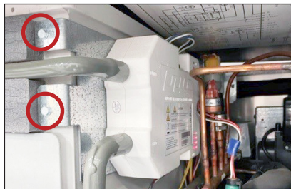
Рис. 3. УФ-система TRUEZONE, вид сбоку. Места установки винтов для крепления кронштейна блока TRUEZONE.
