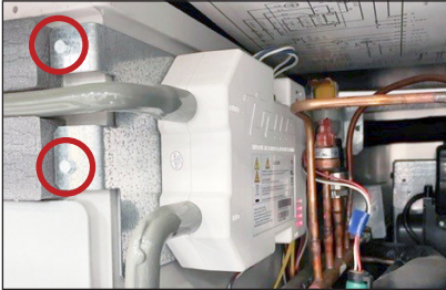
Rys. 3. Widok z boku systemu UV TRUEZONE. Położenie śrub wspornika TRUEZONE.
