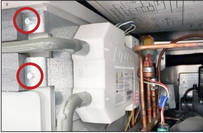
Fig. 3 Vista laterale del Sistema UV TRUEZONE. Ubicazioni delle viti della staffa TRUEZONE.
