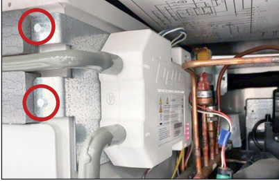
Abb. 3. Seitenansicht des TRUEZONE UV-Systems. Position der Schrauben der TRUEZONE-Halterung.
