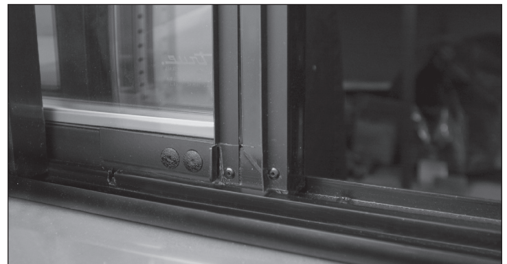
Fig. 2. La serratura dello sportello è in posizione chiusa (disinnestata dall'incavo).
