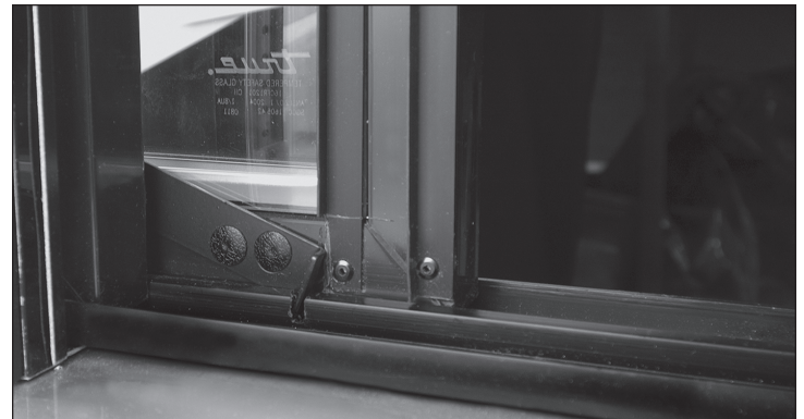
Fig. 1. La serratura dello sportello è in posizione aperta (innestata nell'incavo).
