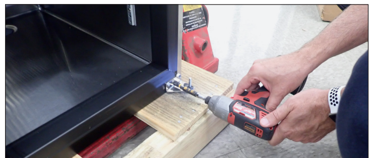
Fig. 7. Posez la charnière inférieure sur le côté opposé de l'ouverture de la porte.
