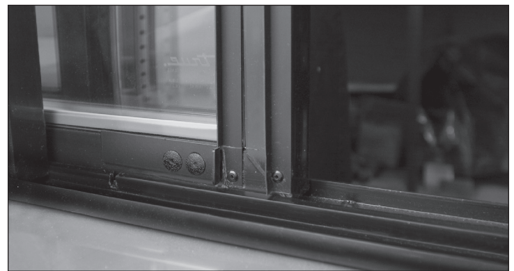
Fig. 2. Le verrou de la porte est en position fermée (désengagé de l'encoche).
