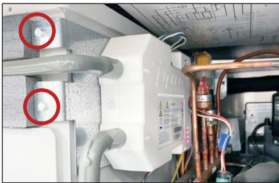
Fig. 3. Vista lateral del sistema de luz ultravioleta de TRUEZONE. Ubicaciones de los tornillos del soporte de TRUEZONE.
