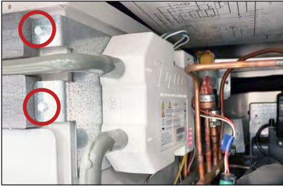
Рис. 3. УФ-система TRUEZONE, вид сбоку. Места установки винтов для крепления кронштейна блока TRUEZONE.
