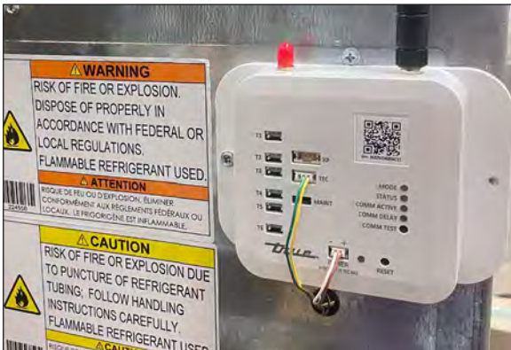
Fig. 2. Faisceau raccordé au modem. Jaune/vert sur TEC ; marron/blanc sur POWER.
