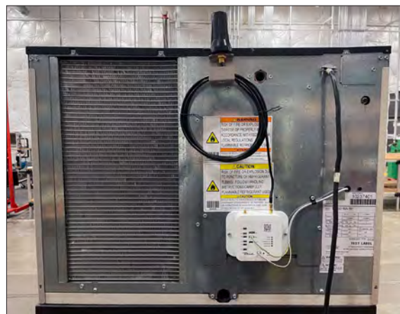
Fig. 3. Antenne installée sur le modem. Votre antenne peut être différente.
