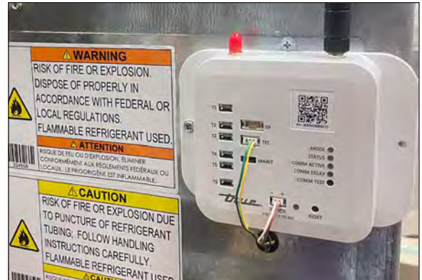
الشكل 2. مجموعة أسلاك متصلة بجهاز الوصل. توصيل الأخضر/ الأصفر ب- TEC؛ والبني/ الأبيض بمصدر الطاقة.
