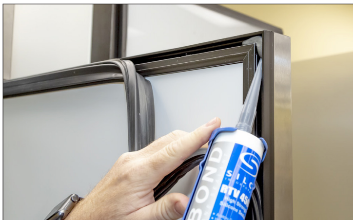
Рис. 3. Нанесите силикон в каждом углу направляющей уплотнителя.
