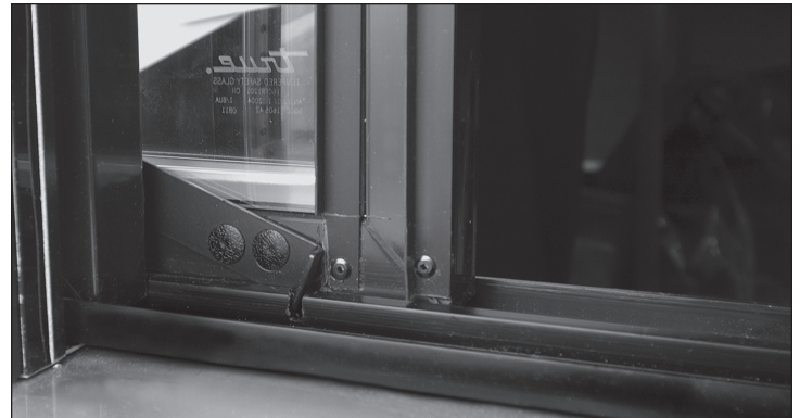
Abb. 1. Feststellriegel geöffnet (in Nocke eingerastet)
