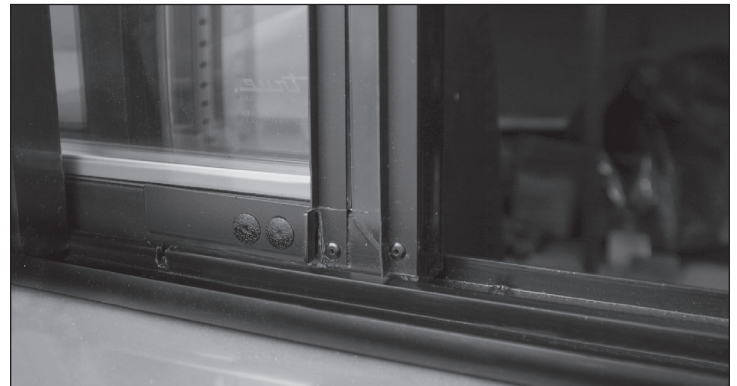
Abb. 2. Feststellriegel geschlossen (nicht in Nocke eingerastet)
