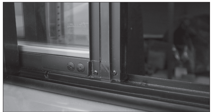
Fig. 2. Le verrou de la porte est en position fermée (désengagé de l'encoche).
