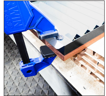
Afb. 2. Centreer de bekleding en het rooster bij de hoeken. Het paneel is iets groter dan het rooster.
