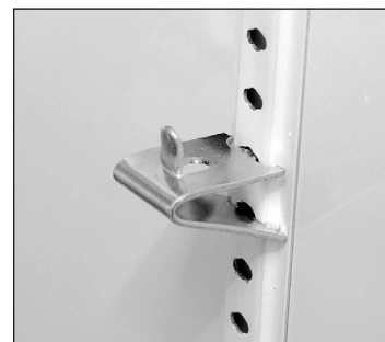
Рис. 4. Кронштейн под полку после установки.
