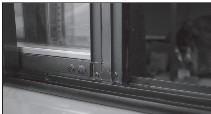
Рис. 2. Защелка дверцы в закрытом положении (не зафиксирована)
