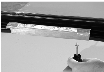
Fig. 2: Remova o suporte de transporte das portas pivotantes de vidro, se estiver instalado. Não descarte.
