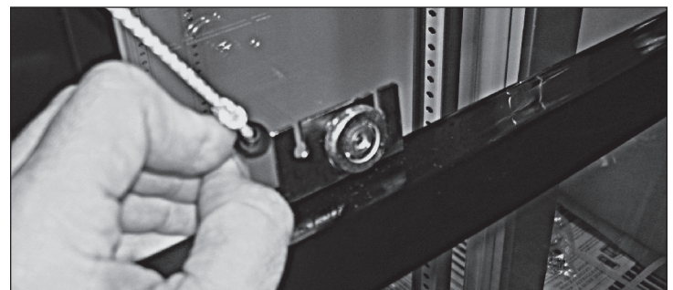
Fig. 8: Deslize a aba preta segurando o cabo da porta para fora da parte de trás do suporte do rolete.
