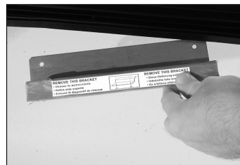
Fig. 2: Remova o suporte de transporte das portas pivotantes de vidro, se estiver instalado. Não descarte.
