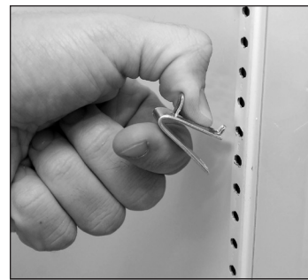
Fig. 1: Colocação da aba superior do grampo da prateleira
