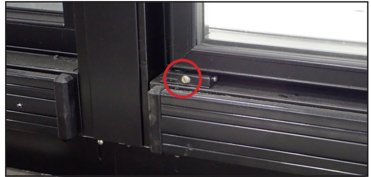
Fig. 4. Ubicación del tornillo de ajuste de tensión de la puerta en la parte inferior de la puerta.
