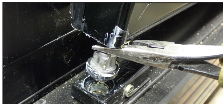
Fig. 7. Un assistant soulevant la tige de torsion du trou du torque master pendant que le technicien soulève la porte.
