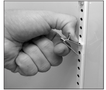
Afb. 7. De onderste lip van de drager past strak in de rail.
