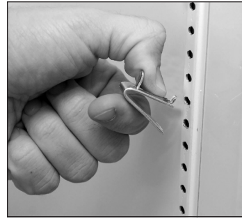
Afb. 6. De bovenste lip van de plankdrager monteren.
