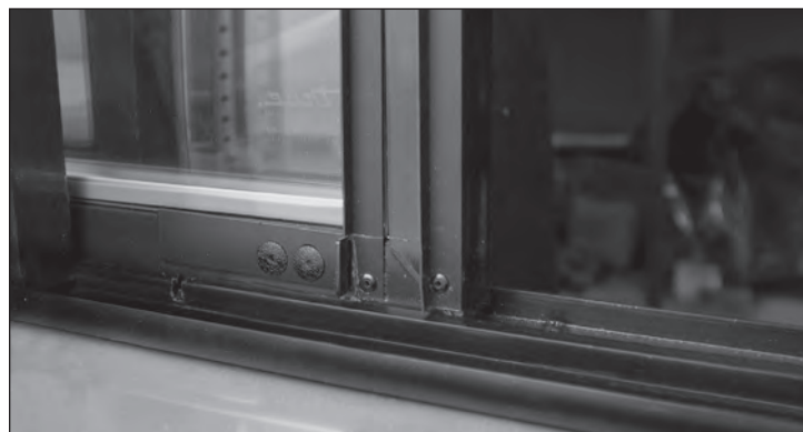
Рис. 2. Защелка дверцы в закрытом положении (не зафиксирована)
