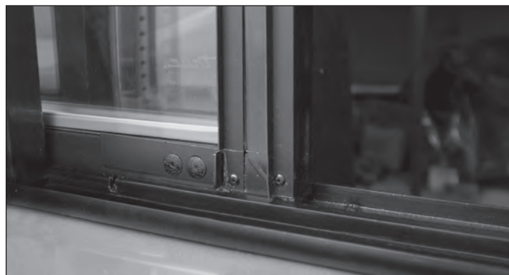
Sl. 2. Vođica vrata je u zatvorenom položaju (odvojeno od vođice).
