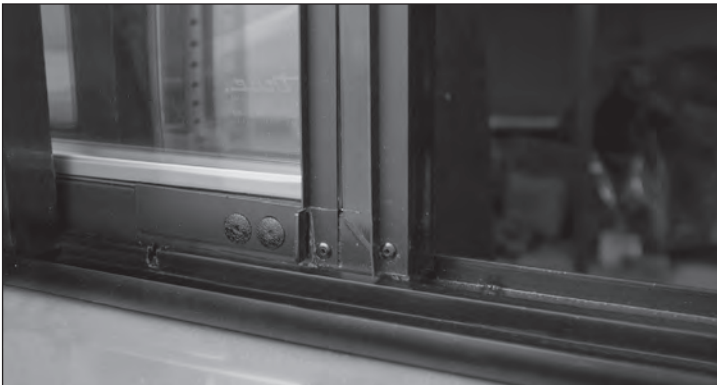
الشكل 2. مزلاج الباب في الوضع المغلق (مفصول عن الندبة).
