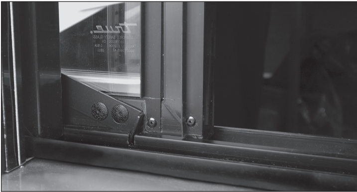
الشكل 1. مزلاج الباب في الوضع المفتوح (متصل بالندبة).
